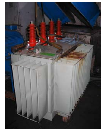
Photo 7 : Transformateur hors service de la centrale électrique de MAMWE, Moroni
